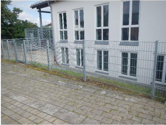
Abbildung 2.5: Beispiel für Kellerräume Grund- und Mittelschule Teisendorf (Ortseinsicht am 09.08.2024)
