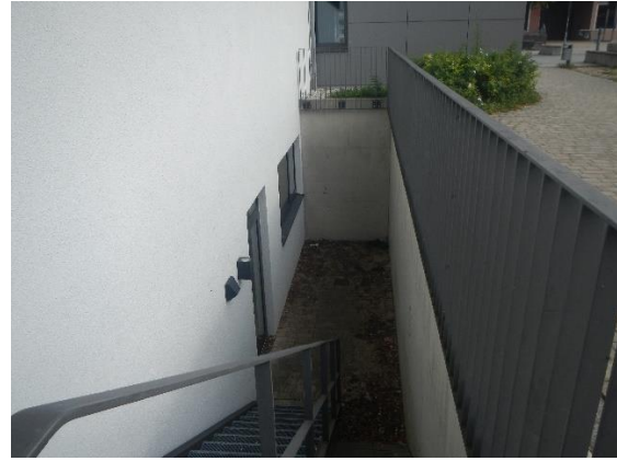
Abbildung 2.6: Beispiel für Kellerräume Sporthalle Teisendorf (Ortseinsicht am 09.08.2024)
