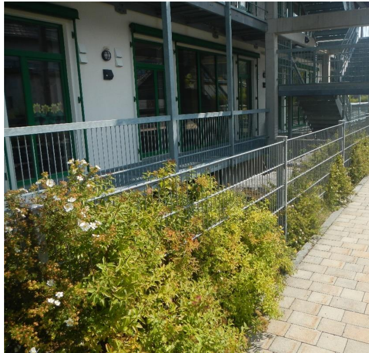
Abbildung 2.3: Südseite der Grundschule Oberteisendorf mit Kellerräumen und schützender Mauer (Ortseinsicht am 09.08.2024)
