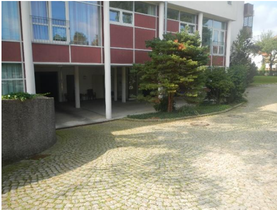
Abbildung 2.7: Anlieferung/Zufahrt Seniorenwohn- anlage Teisendorf (Ortseinsicht am 09.08.2024)
