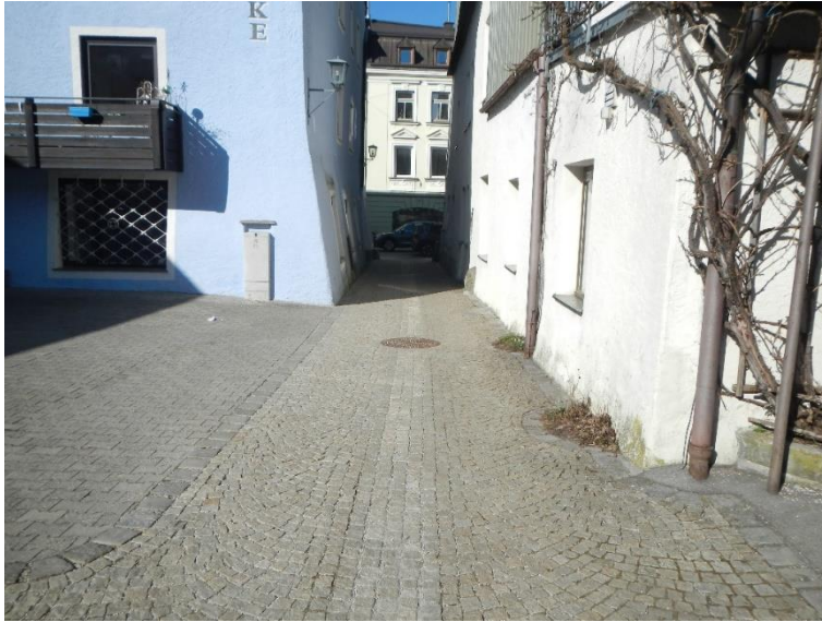
Abbildung 10.4: Hangseitiger Verzicht auf Zuströmöffnungen, Ortseinsicht aquasoli am 20.03.2022
