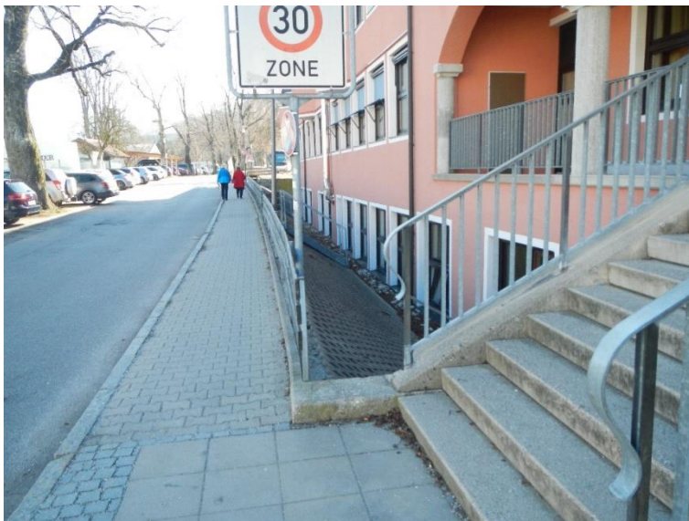
Abbildung 10.3: Wasserführung durch Objektschutz wie Mauerstrukturen, Ortseinsicht aquasoli am 20.03.2022
