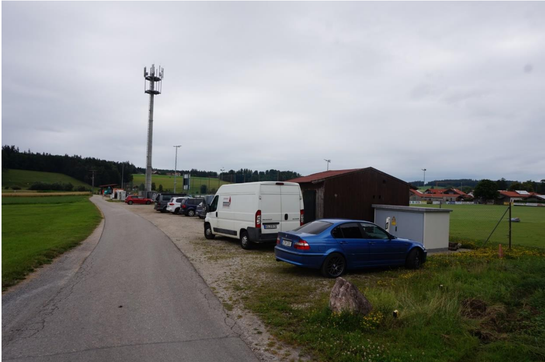
Abb. 7: Zufahrtsstraße mit Parkplätzen und Funkmast, Blick in Richtung Nord
