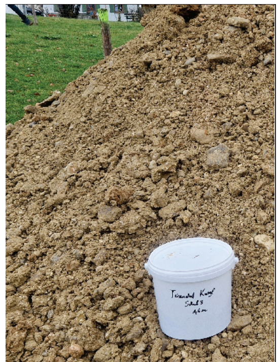
Abbildung 9: Foto Bodenaufschluss Schurf Nr. 3 mit Benennung der angetroffenen Bodenschichten und Bodenprobe 2
