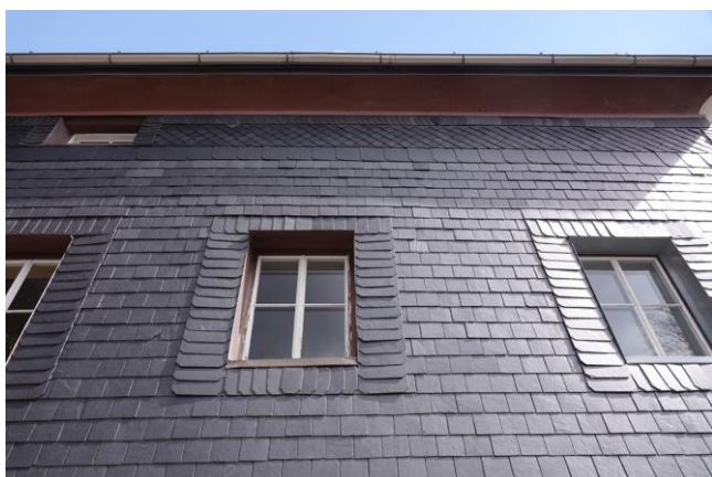
Abbildung 7: Wandverkleidung mit Schieferplatten.
