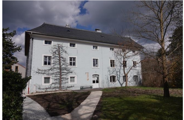
Abbildung 4: Südansicht des Gebäude A.
