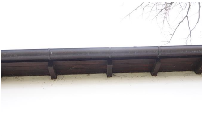
Abbildung 21: Übergang Dachkonstruktion Außenmauer.
