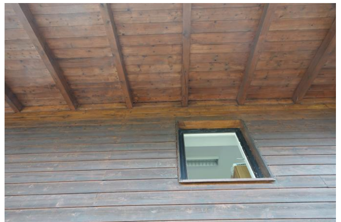
Abbildung 22: Übergang Dachkonstruktion Außenwand.
