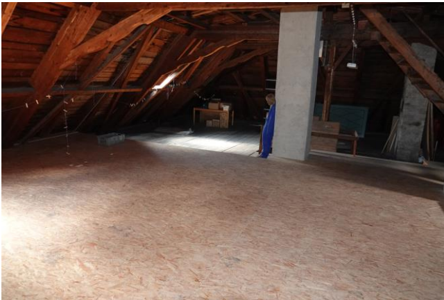
Abbildung 9: Übersicht des Dachbodens Gebäude A.
