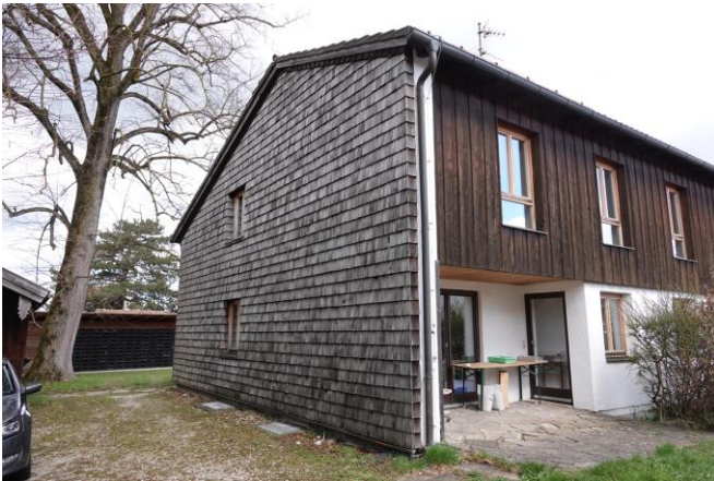
Abbildung 19: Holzvertäfelung der Außenmauer Richtung Westen.
