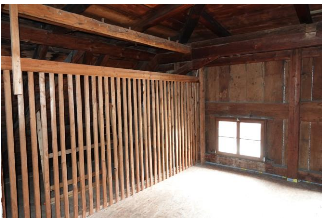
Abbildung 11: Übersicht des Dachbodens Gebäude A.
