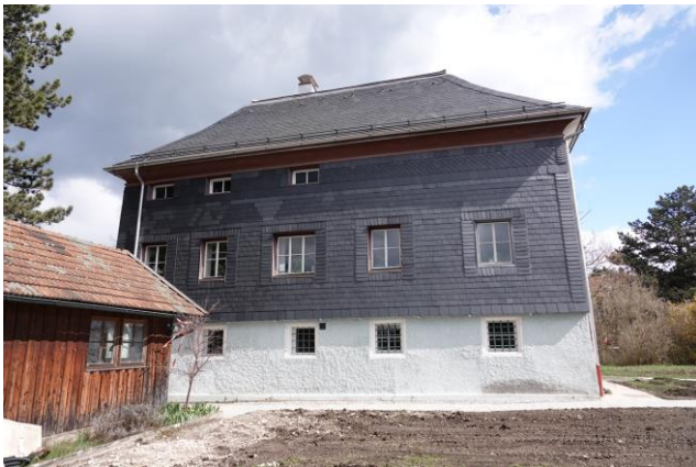
Abbildung 5: Westansicht Gebäude A.
