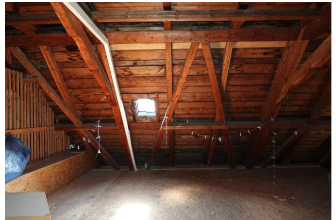
Abbildung 10: Übersicht des Dachbodens Gebäude A.
