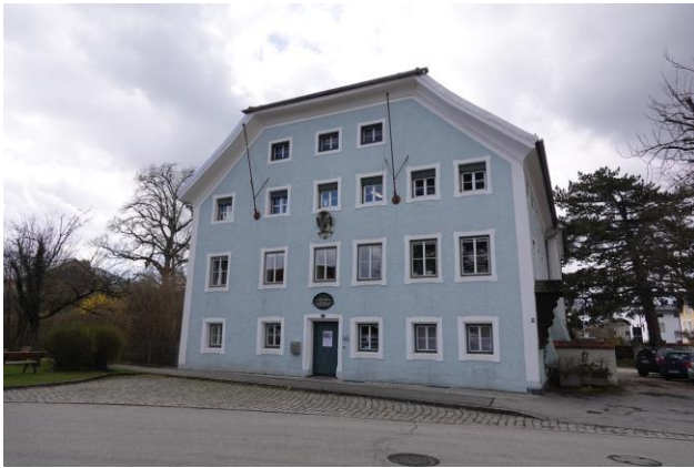
Abbildung 3: Ostansicht Gebäude A.
