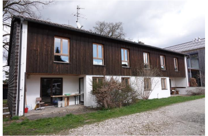
Abbildung 18: Ansicht des Gebäudes B aus südlicher Richtung.
