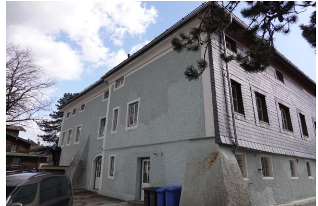
Abbildung 6: Nordwestansicht Gebäude A.
