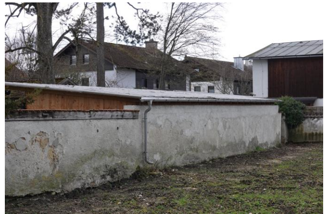
Abbildung 30: Rückseite der Scheune, unterhalb des Anbaus befinden sich Garagen.
